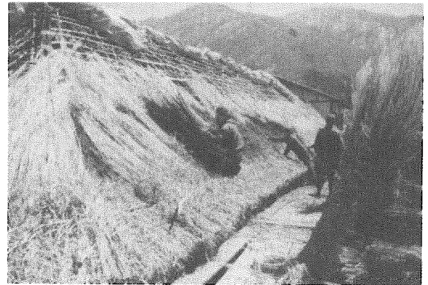
カヤで屋根を作る作業
